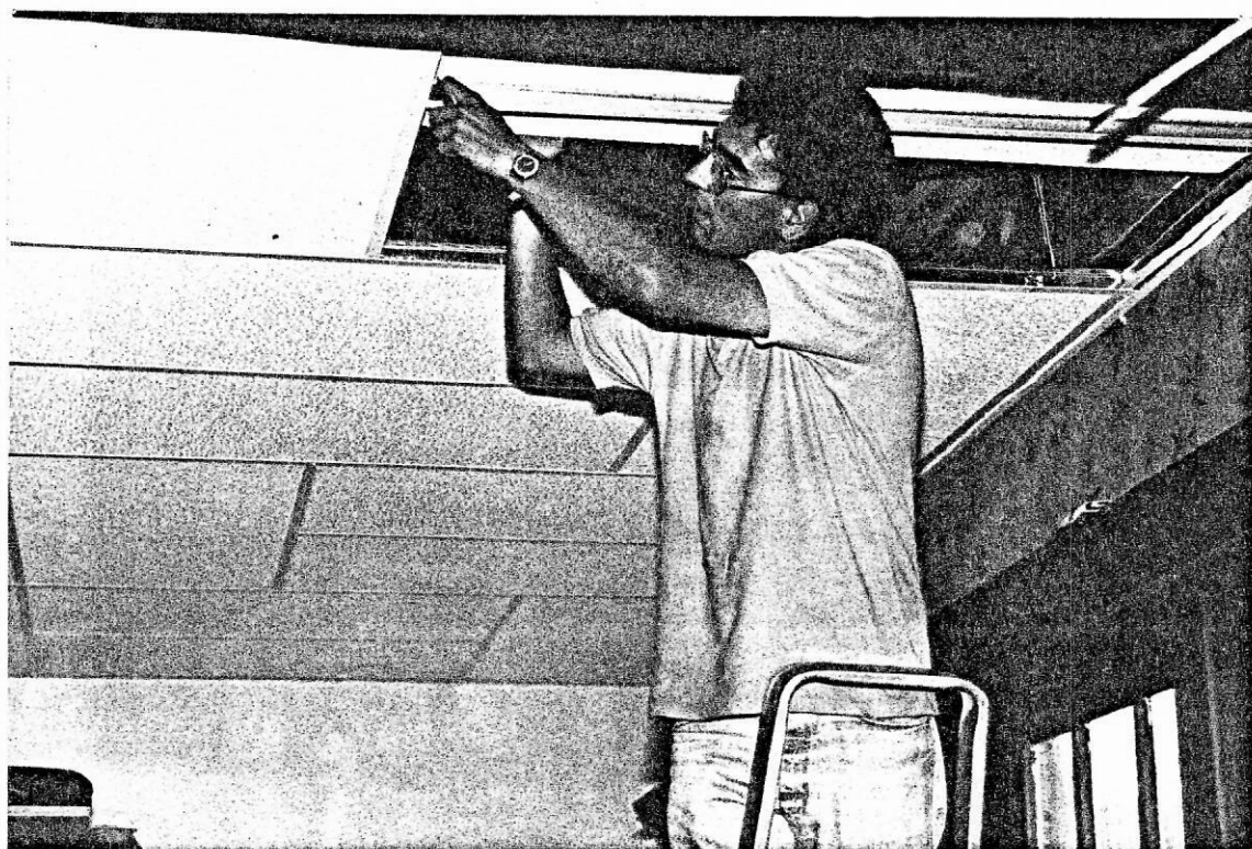
foto 3,4: Afwerking van de eerste helft van het plafond.
