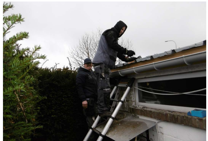
Carlo en co zorgden voor een nieuwe dakgoot
