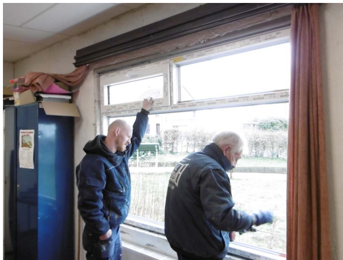
Er werd een nieuw raam geplaatst in het briefinglokaal.
