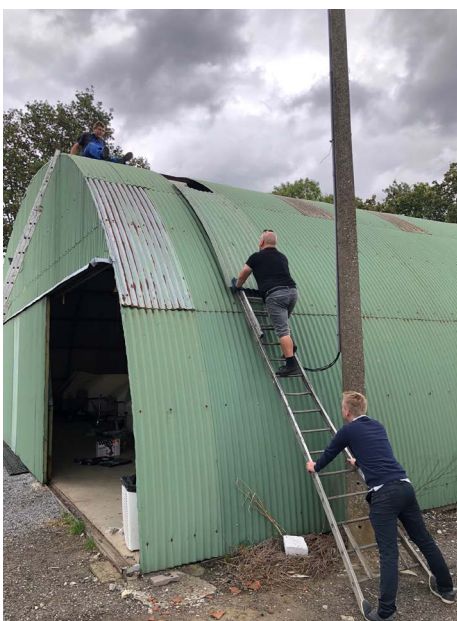
Herstelling dakplaten hangar privé
