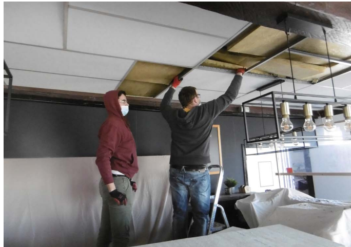
Sam en Dimitri vervangen de plafondpanelen
