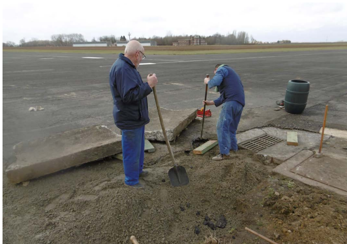
Wim en Hugo bij het herstellen van de goot
