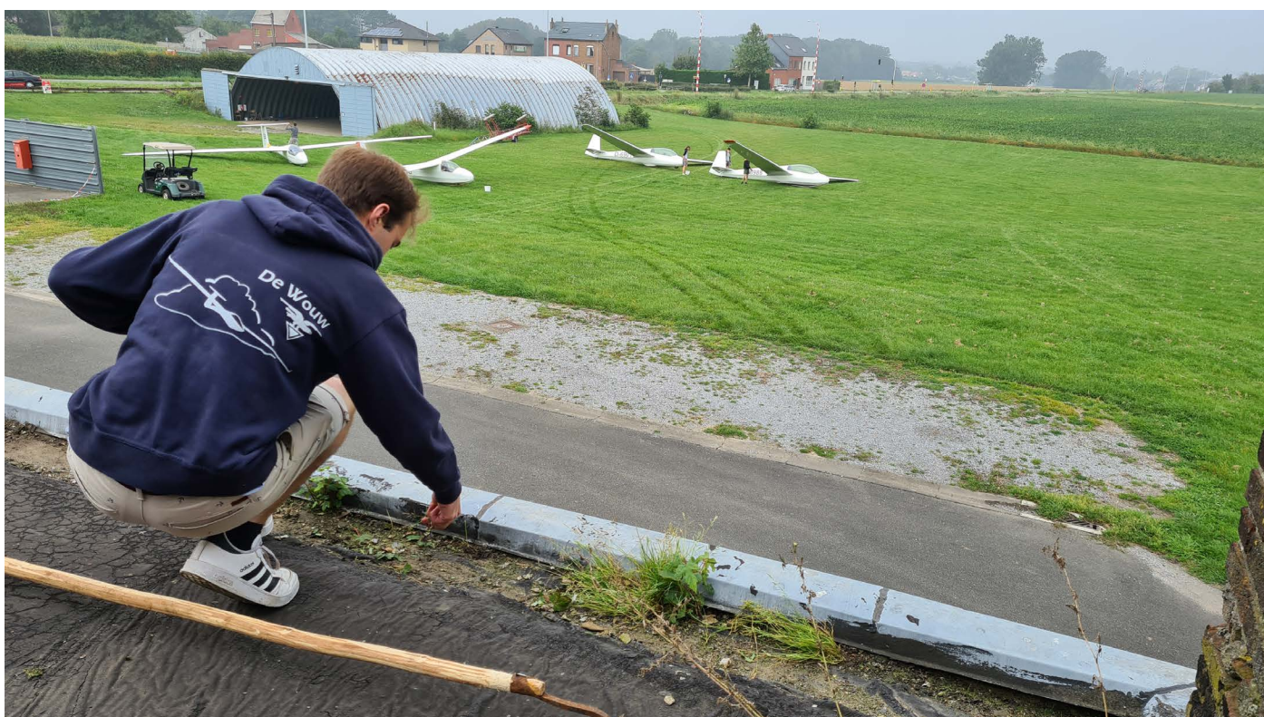
Controle van de daken van Hangar Zuid, Noordkant
