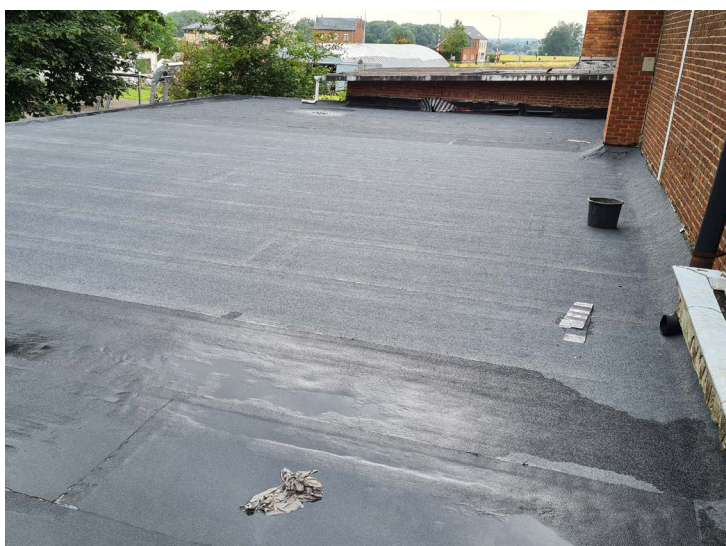
Vernieuwen van de roofing boven de werkhuizen...
