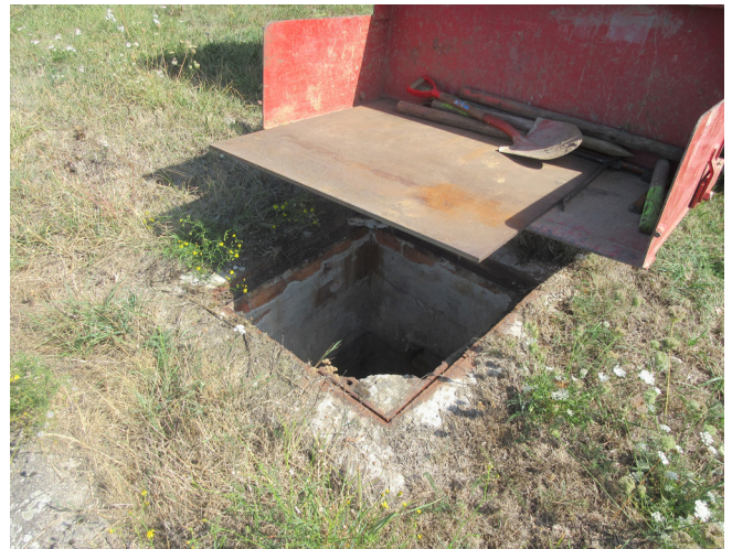
Een stukgereden deksel langs de piste wordt gedicht.
