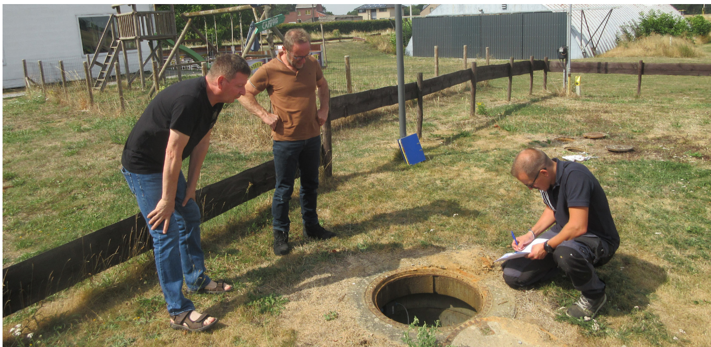
Controle van de tankinstallatie
