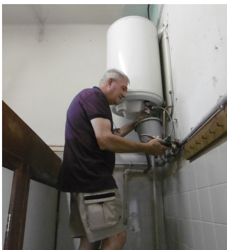
Rudi herstelt de boiler van de douches
