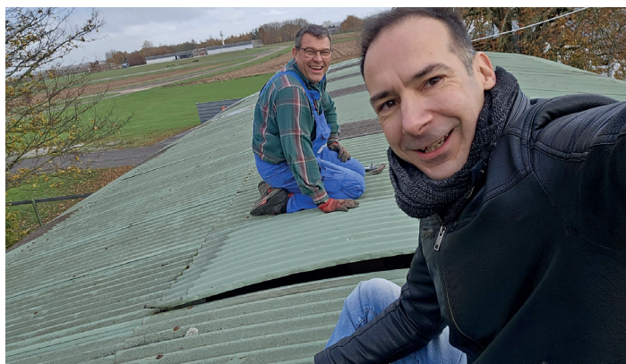
Rudi en Mattijs herstellen de stormschade aan de hangar privé
