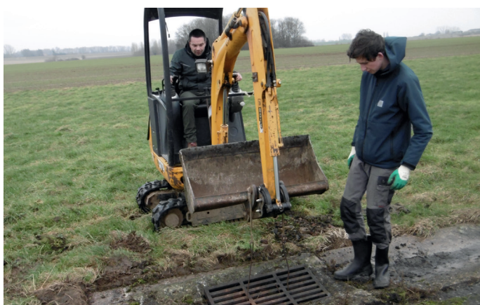
Daan en Arthur bij het kuisen van de rioolputten
