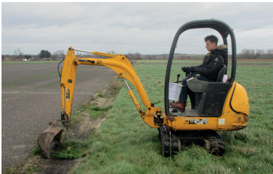
Jens bij het kuisen van de goten langs de landingsbanen.
