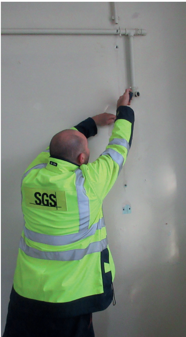
Inventarisatie van asbest in onze clublokalen.
