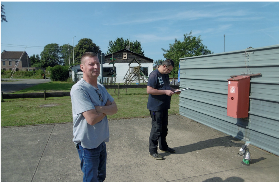
Keuring van de pomp door ATK
