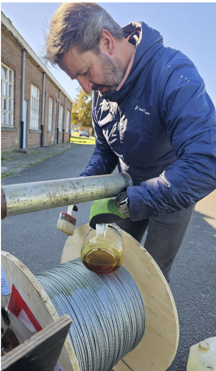
Een nieuwe lierkabel wordt geplaatst
